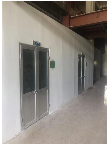
图 7 一般固废储存区现场照片
